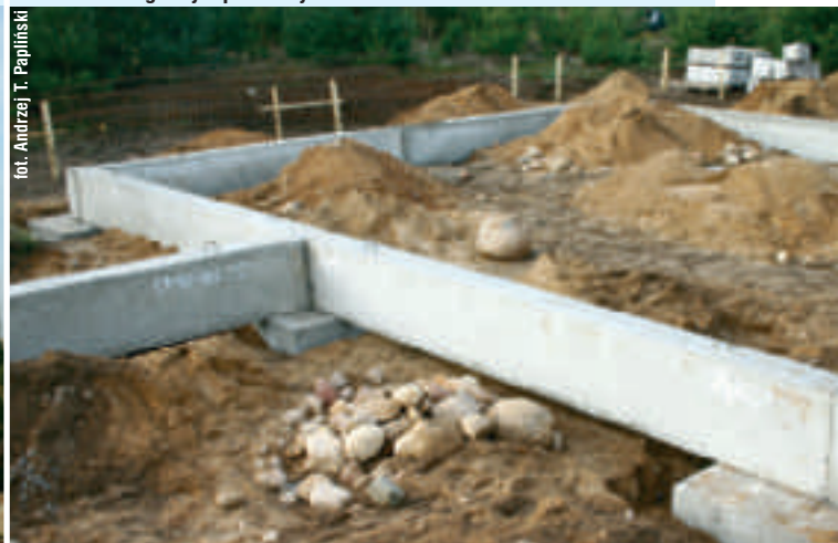
↓ Fundament jest skręcany z prefabrykowanych belek, osadzonych na betonowych blokach, które wykonuje się poprzez wypełnienie metrowego wykopu chudym betonem
