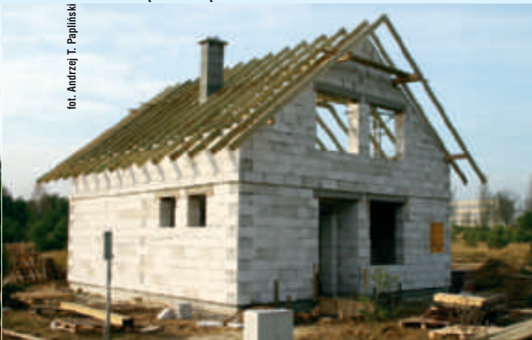
↓ Najprostsza technologia: ściany jednowarstwowe z bloczków betonowych, strop z płyt kanałowych, ścianka kolankowa i dwuspadowy dach pokryty dachówką betonową
