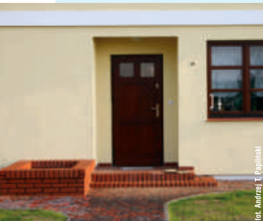
↑ Anatomia urody małego domu: ocieplenie wieńca jako element podziału elewacji, cofnięte wejście, podział okien zgodny z lokalną tradycją, donica z cegieł przy wejściu
