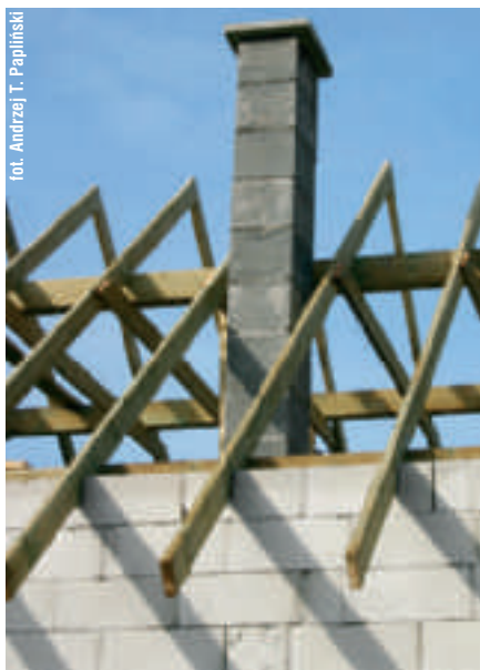
↑ Komin budowany jest opcjonalnie – tylko do kominka, bo kocioł grzewczy ma zamkniętą komorę spalania
